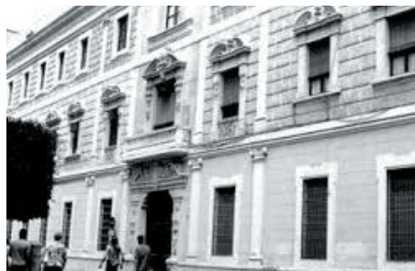
Vista lateral en blanco y negro de la fachada del edificio del Gobierno Militar. amigosdelamili.com/
