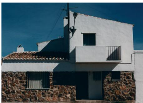
Vivienda de colono de dos plantas. El muro de mampostería en la planta baja alcanza una altura de dos metros
