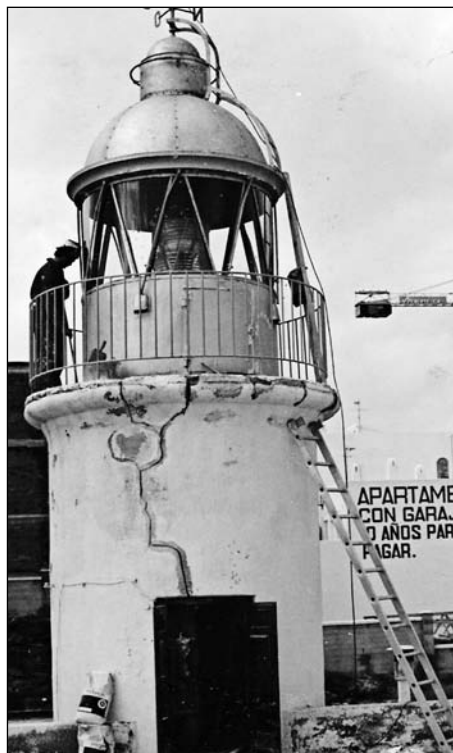
Reparaciones en el faro de Garrucha. Foto Felipe Ortiz
