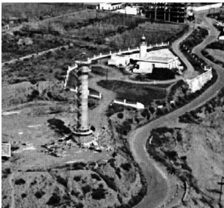
Segundo faro de Adra y torre del tercero en construcción. Foto libro “Faros españoles del Mediterráneo” de Miguel Ángel Sánchez Terry
