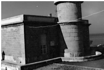
Segundo faro de Adra sin linterna. Foto Felipe Ortiz
