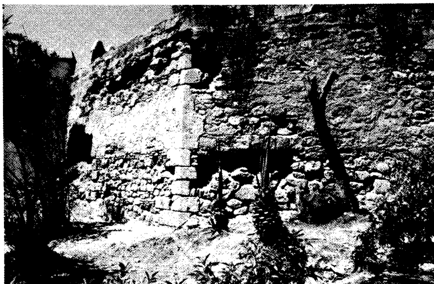
Lám. 7. Muros de Baluarte de la Campana con una tronera al fondo.
