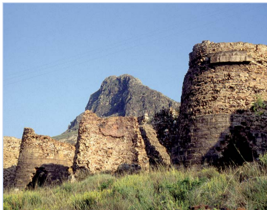
Restos de los hornos de calcinación de Lucainena de las Torres, importante centro minero del s. XIX en la provincia.
