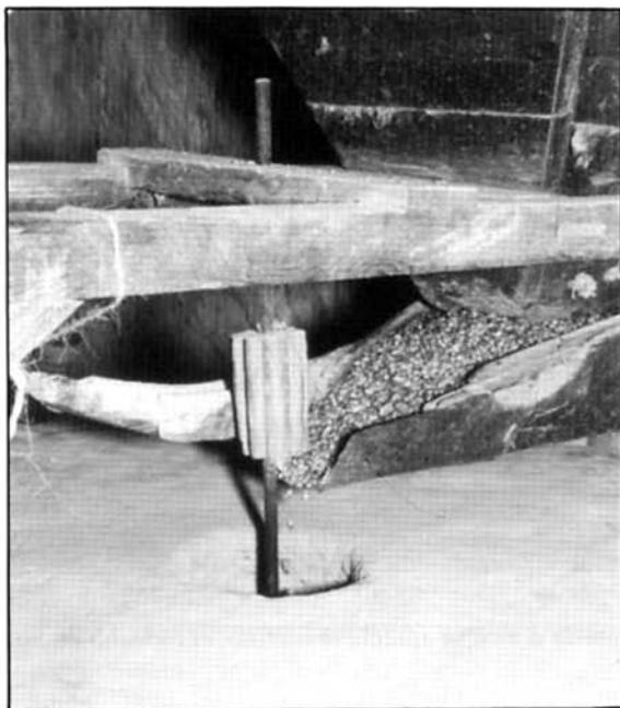
Fig. 14. El grano conducido por la *canaleja* cae sobre el *ojo* de la *corredera*.
