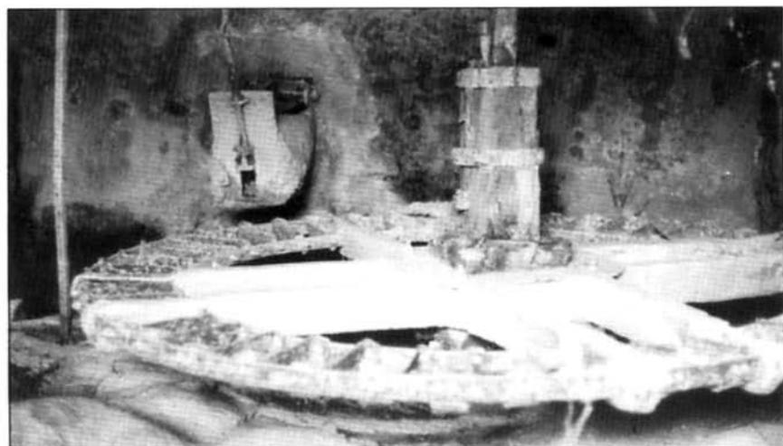
Fig. 12. La bóveda donde se aprecia el saetillo, el rodezo de turbina y el eje.
