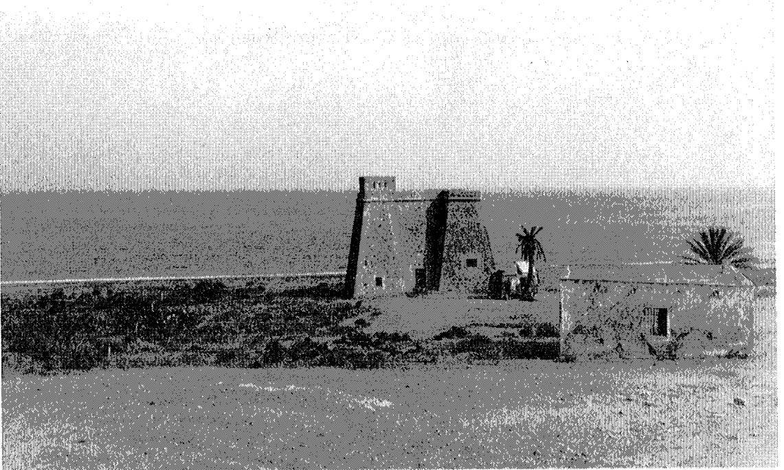
Torre de Macenas: Por la parte que da al mar es semicircular para el emplazamiento de piezas de artillería; la parte que da a tierra tiene forma de hornaveque. Es una típica torre artillada.
