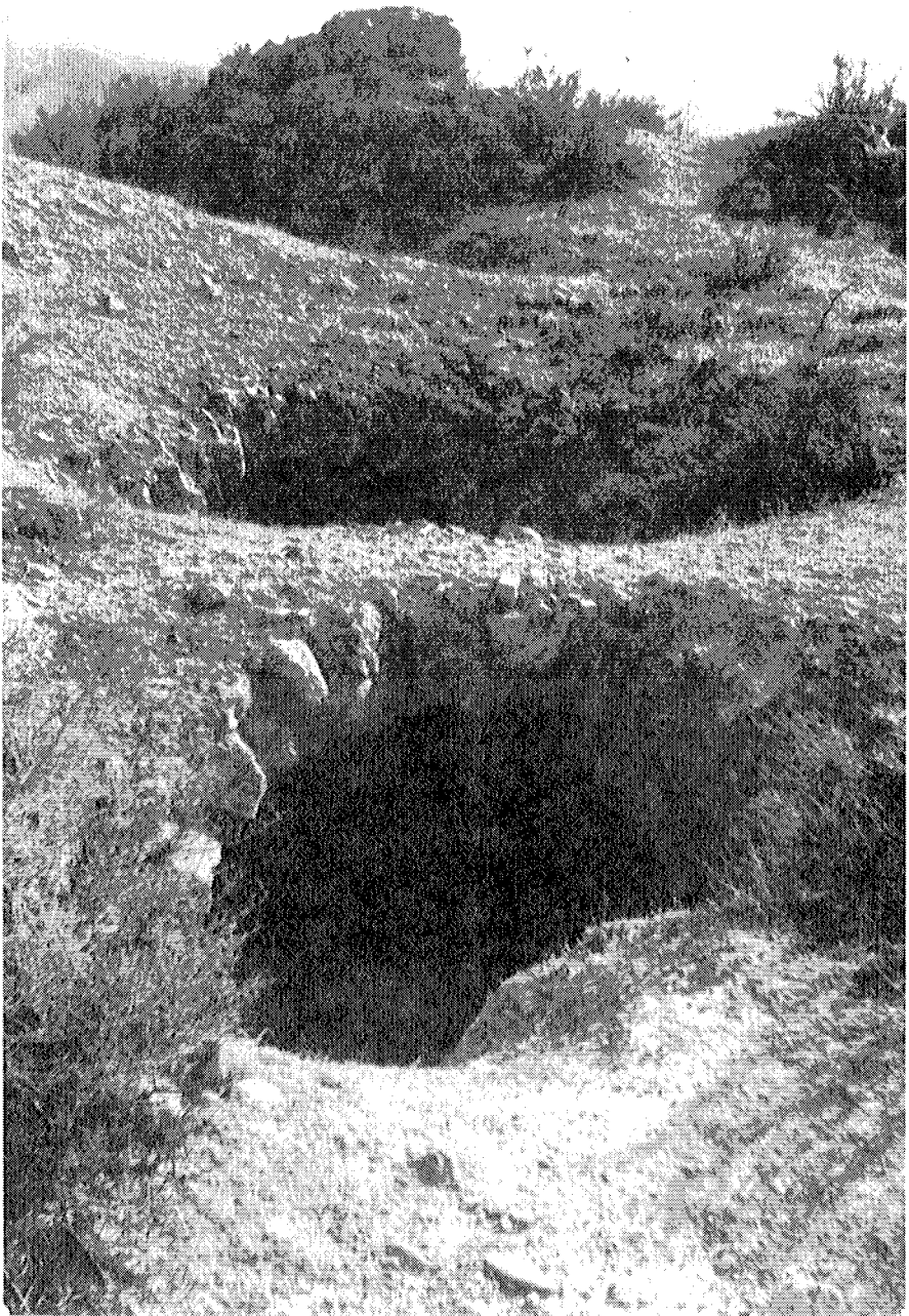
Lám. 9.— Aljibe del segundo recinto de la alcazaba, el mejor conservado.
