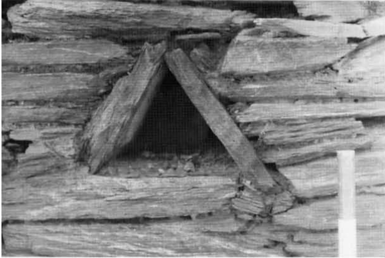
Lám. IV. Cuesta Roca (Senés). Nicho triangular en el muro sur (104) del patio.
