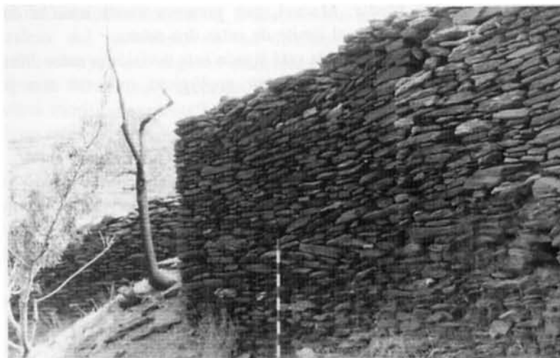
Lám. II. Cuesta Roca (Senés). Opus spicatum en la fachada norte (muro 113).
