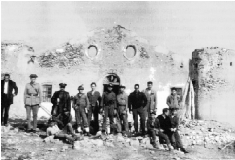
Ruinas de la Zarba (Marchal de Enix)
