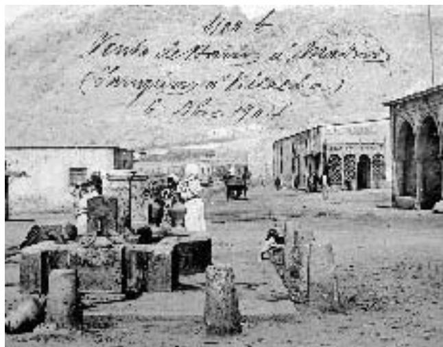
Fuente de abastecimiento público en la zona de San Antón.
