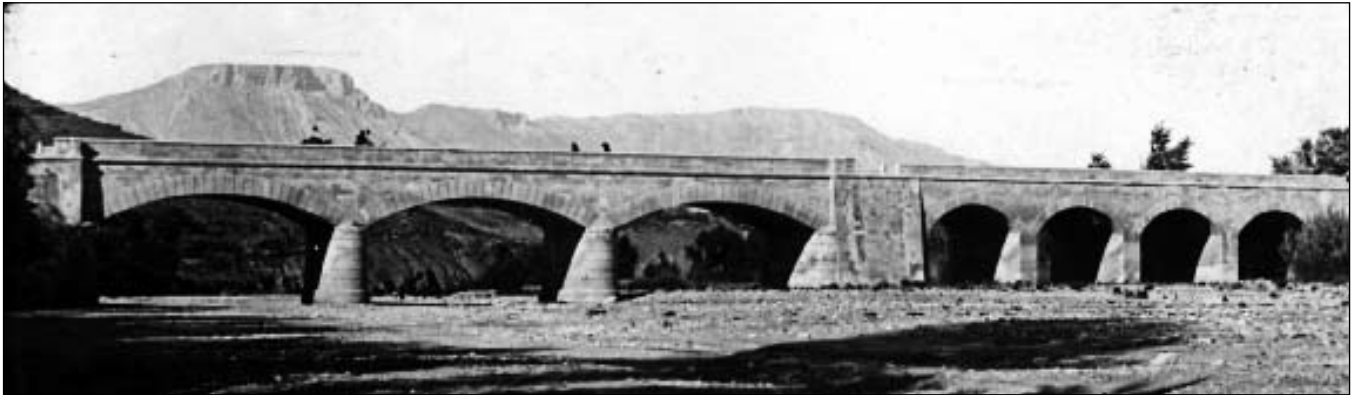
El famoso Puente de los Siete Ojos, sobre el cauce de la Rambla de Chirivel, a unos 2 kms de Vélez Rubio; obra fundamental para la comunicación de los Vélez con Lorca, fue terminado en los primeros años de la década de los 80 del s. XIX.
