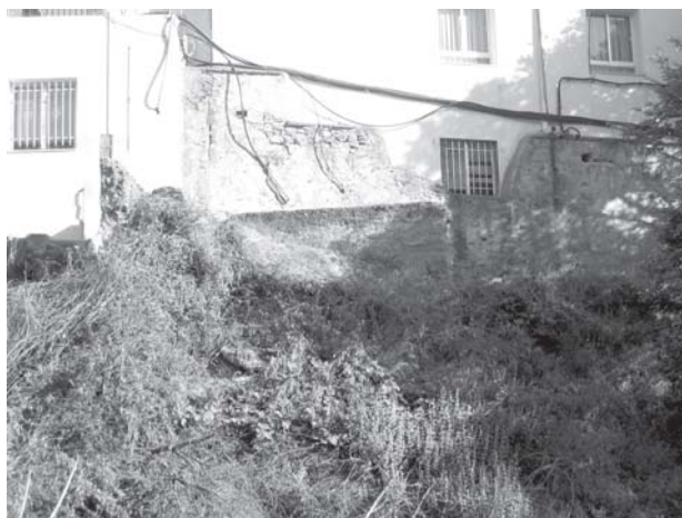
Aún hoy día se pueden apreciar algunos restos del antiguo hospicio mínimo de Ntra. Sra. de Gádor, insertos en los propios muros del convento actual.
