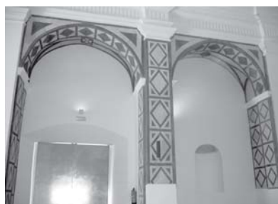
Interior de la portada lateral del convento de los mínimos de Vera.
