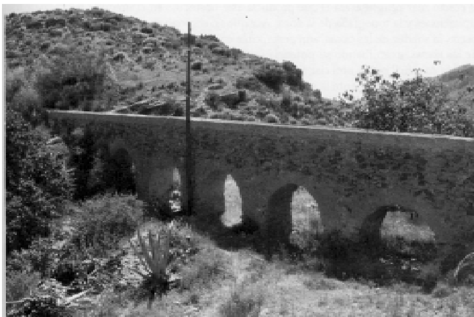
Acueducto del Molino Salinas I o de Arriba (Vicar).
