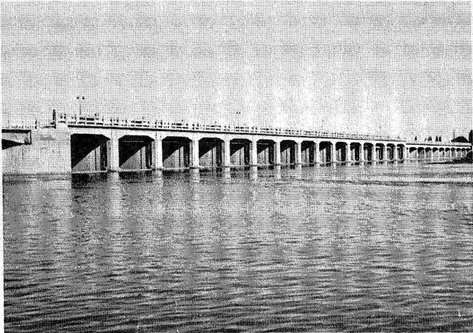
Dique de derivación Cipolletti sobre el río Mendoza, punto de partida del sistema de riego del oasis principal.
