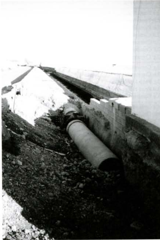
Oras de entubamiento del Canal del Sector III
