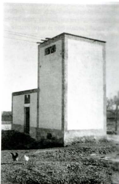
Mejora auxiliada por la Legislación de Colonizaciones de Interés Local. Dalías, EL Ejido, Balsa del Sapo. Mejora: Grupo electrobomba y línea. 1949.
