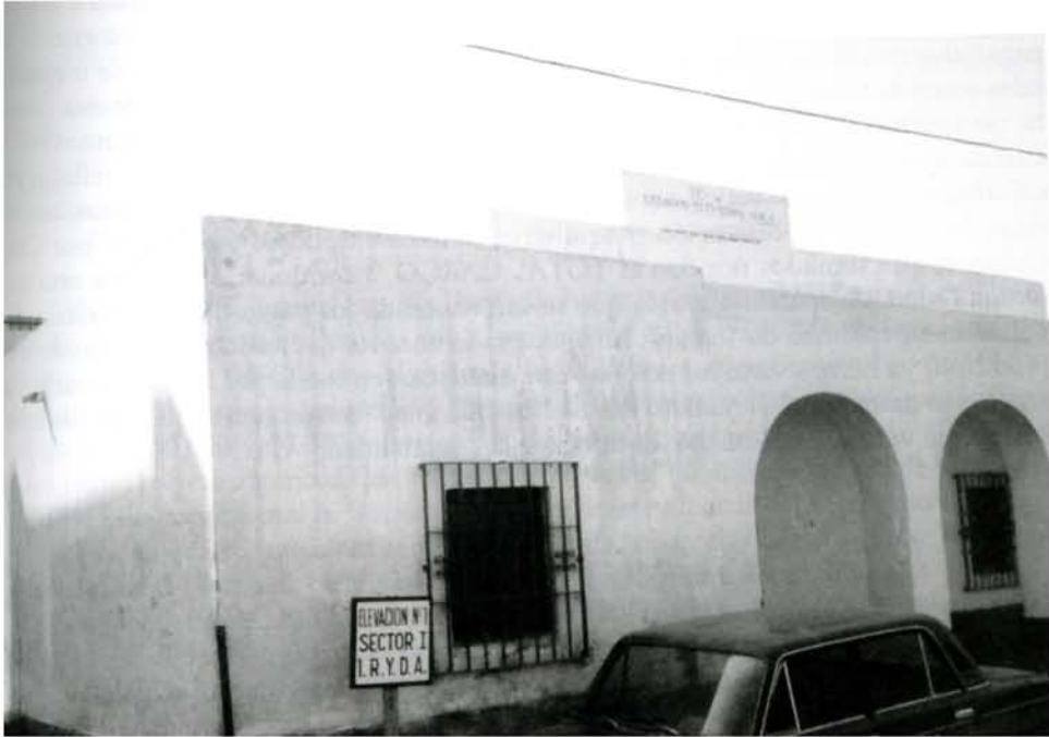
Estación elevadora n° 1. Venta Vitorino Aguadulce en 1986
