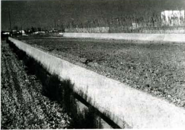
Bancales preparados para ser enarenados, con muros de hormigón a principios de los años sesenta
