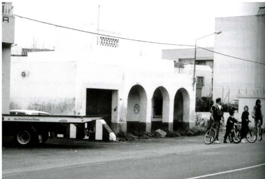
Estación elevadora nº 1 (Venta Vitorino-Aguadulce) en la actualidad
