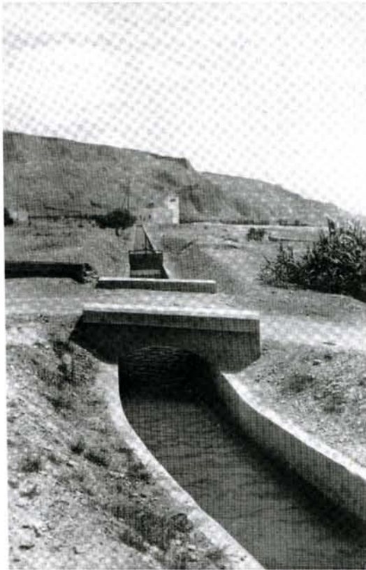
Cauce principal del grupo de elevaciones n° 2 en 1956
