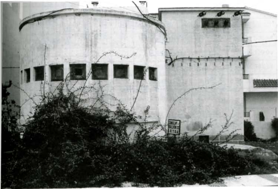
Pozo nº 7 del Sector II
