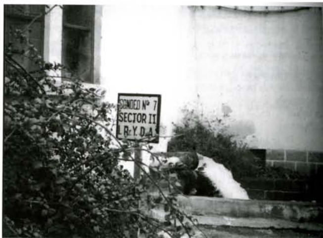
Pozo del Sector II en Aguadulce en 1986 cuando todavía se encontraban en funcionamiento, en la actualidad estos sondeos están abandonados
