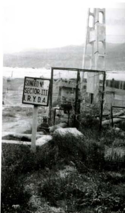
Muchos de los sondeos del Sector III están hoy en día en desuso y han sido sustituidos por otros nuevos
