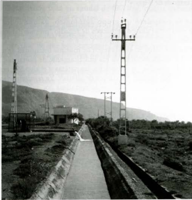
Canal y batería de sondeos en la Zona de Interés Nacional. En primer plano una de las bombas, en segundo una caseta más antigua.
