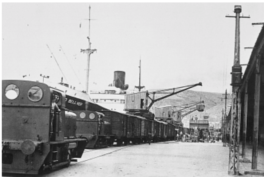
Ilustración 9. Actividad ferroviaria en el puerto de Almería. Años 50. Fondo Asafal
