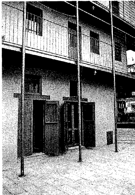
Rehabilitación de una de las corralas.
