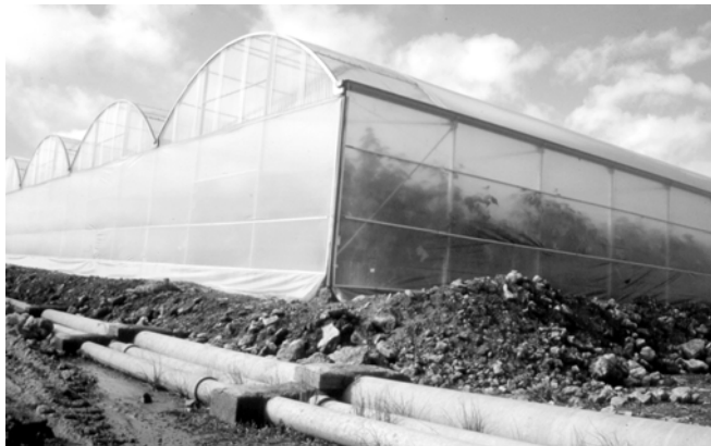
La «estructura multitúnel» está siendo la más utilizada por sus mayores prestaciones en instalaciones avanzadas
