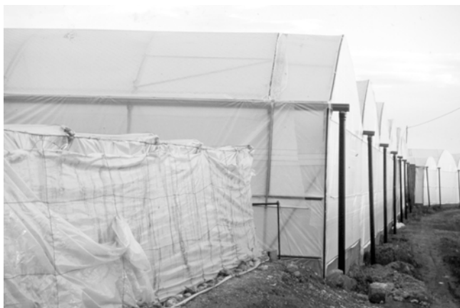
25 años separan estos dos tipos de estructuras, parral y multitúnel
