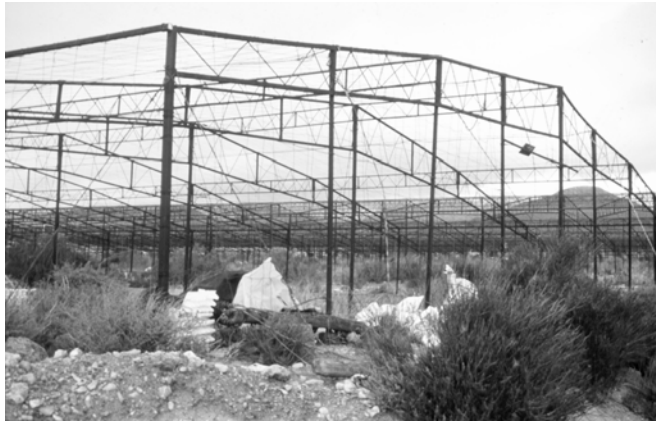
Antigua estructura de invernadero a base de perfiles.
