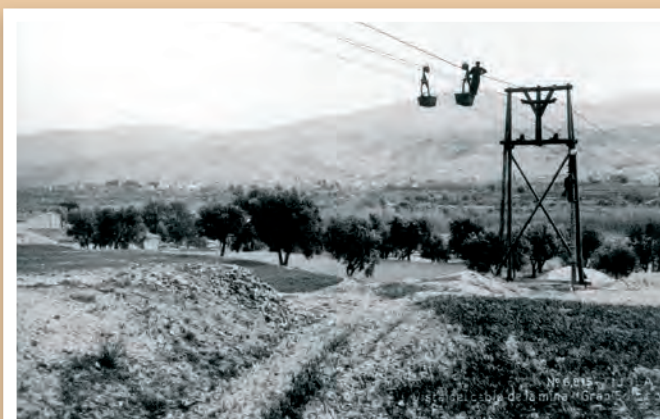
➤ Cable aéreo de la mina Gran Coloso poco antes de llegar al cargadero de Algaida (Porfolio, 1915).
