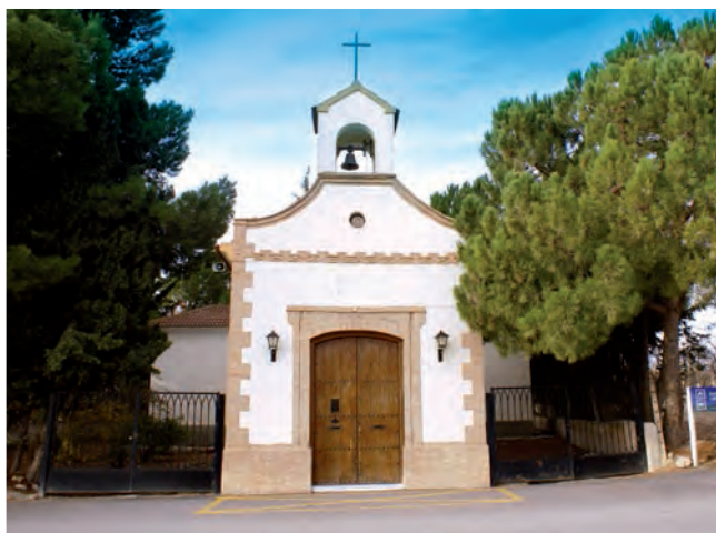
► Fachada de la ermita de Mª Auxiliadora en la barriada de Cela. (Foto: Rafael Pozo Marín)
