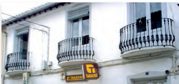
► Las escasas manifestaciones de la arquitectura modernista se ciñen en Tijola a la ornamentación de las rejerías, bien en las barandillas de escaleras o en balcones como estos en la Carrera del Socorro. (Foto: R. Pozo Marín).
