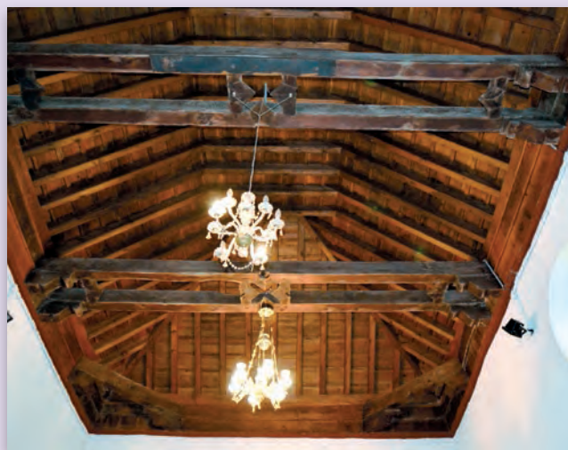
► San Cayetano cubre su pequeño oratorio con una sencilla armadura de limas y dos tirantes dobles. (Foto: R. Pozo Marín).
