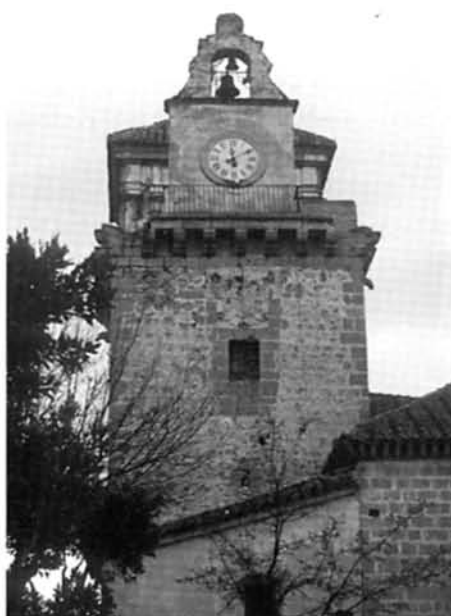
Foto 9 Torre de la Iglesia de Níjar. Originariamente debió ser torre-fuerte
