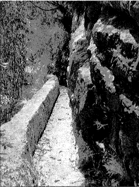
Lám. 2. Detalle de una de las acquias principales del regadío de la huerta de Argelita parcialmente excavada en la roca.
