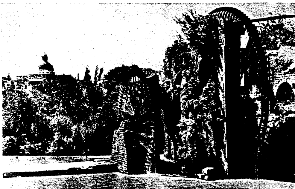
Noria de Hama en Syrie Centrale: grande roue hydraulique à palettes motrices et auges en bois; le cours du fleuve permet l'élévation de l'eau déversée ensuite dans des rigoles. Celle de Tolède, qu'admirait Idrisi au XII e siècle appartenait vraisemblablement à cette catégorie de grandes roues mues par la force du courant. (Photo extraite de D. et J. Sourdel, La Civilisation de l'Islam classique, Paris Arthaud, 1968.)
