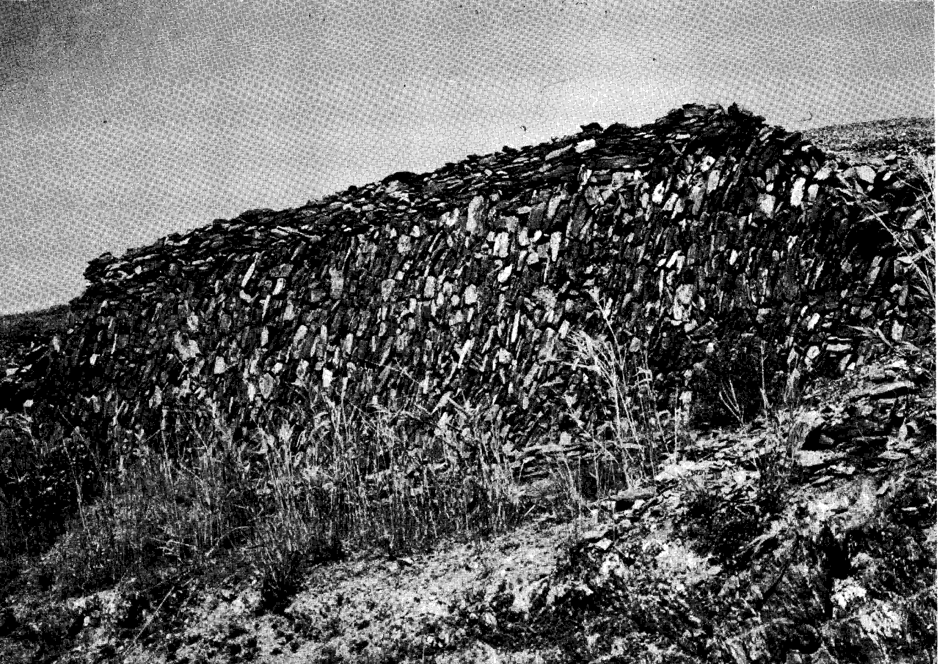
Balate de bancal aterrazado en La Alcazaba (Adra), de casi cinco metros y medio de altura.
