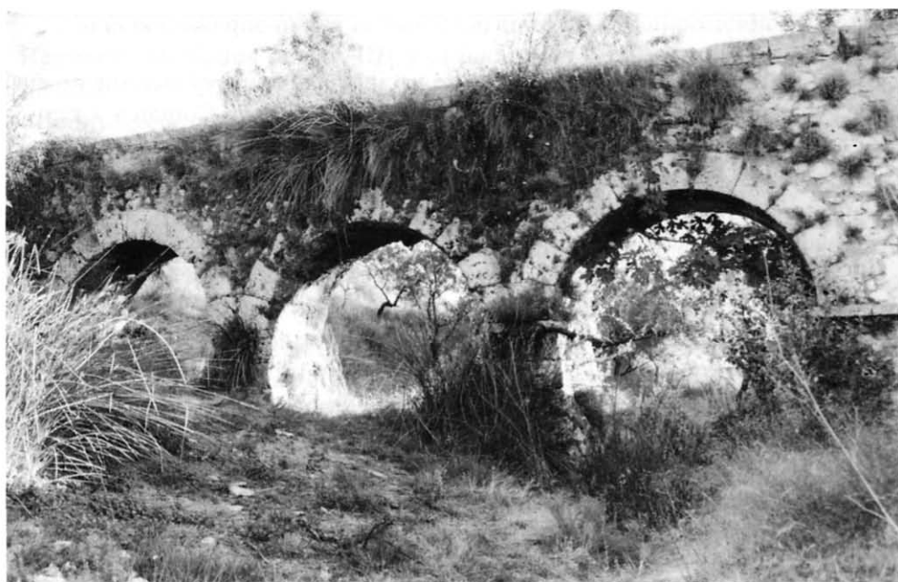
Acueducto del Molino de la Buenavista (V. Blanco)
