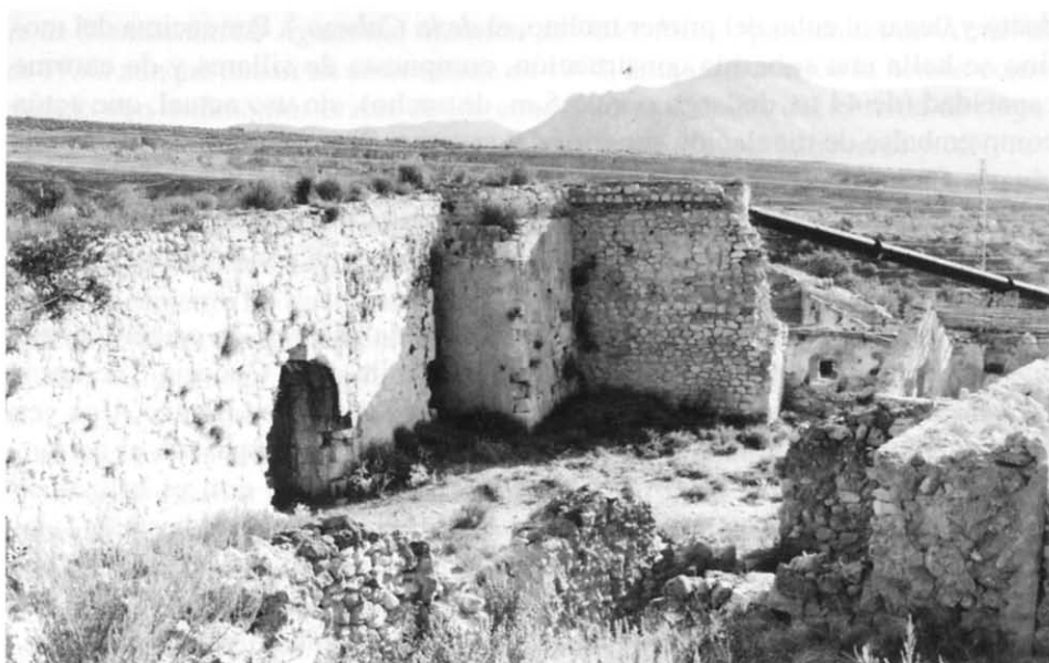
El gran acueducto en piedra de sillería del Molino de la Cabeza. A la dcha, el inicio del tubo metálico instalado a finales del s. XIX para la producción de energía eléctrica
