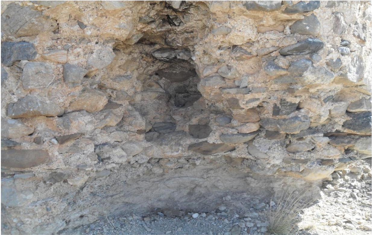
La abertura corresponde a la puerta-ventana es adintelada, situada a unos 5 metros de altura. La torre se asienta sobre una base compacta de mortero más claro que el resto de la construcción, por llevar más cal. No tiene ventanas. La puerta ventana está orientada 330° NW.
