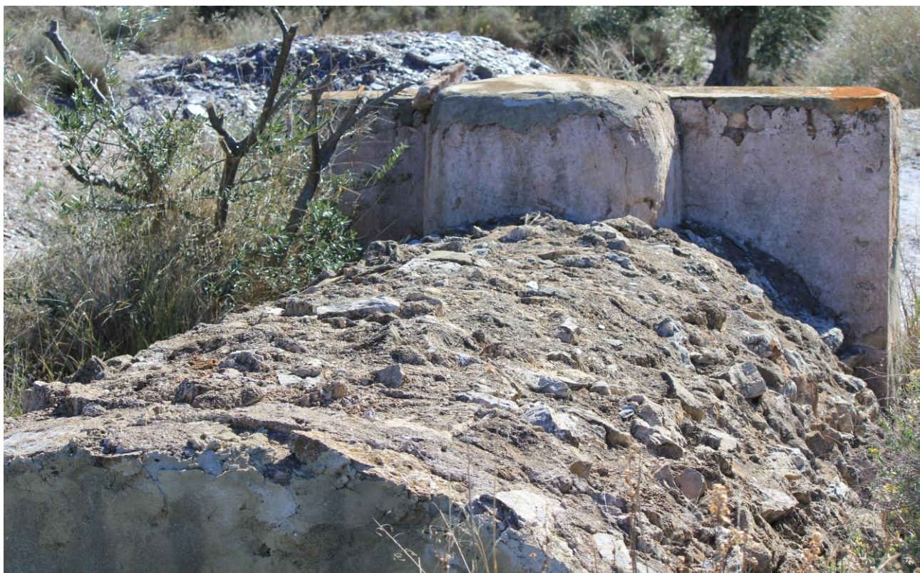
Imagen de tipo de aljibe que existía en la zona
