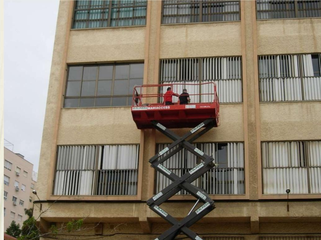
LOS ALUMNOS UTILIZARON UNA PLATAFORMA ELEVADORA PARA LOS TRABAJOS DE DESMONTAJE DE LAS LAMAS EXTERIORES
