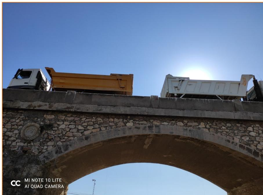
*Prueba de carga en VANO 79*
