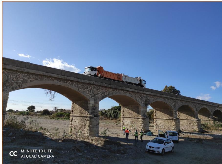
*Prueba de carga en VANO 7*
