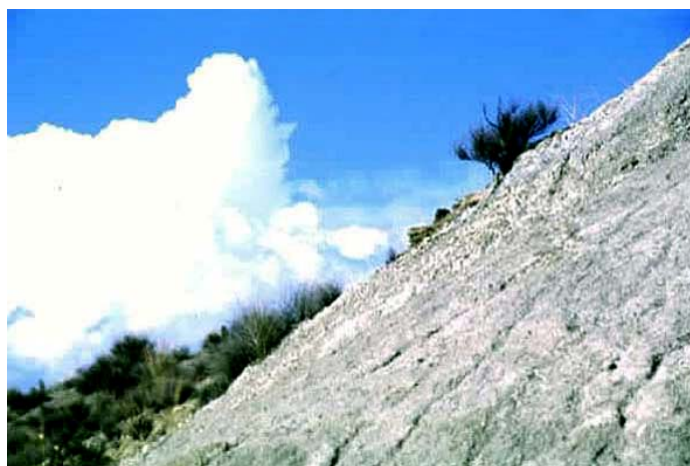
La pendiente y el clima provocan un intenso proceso erosivo.
