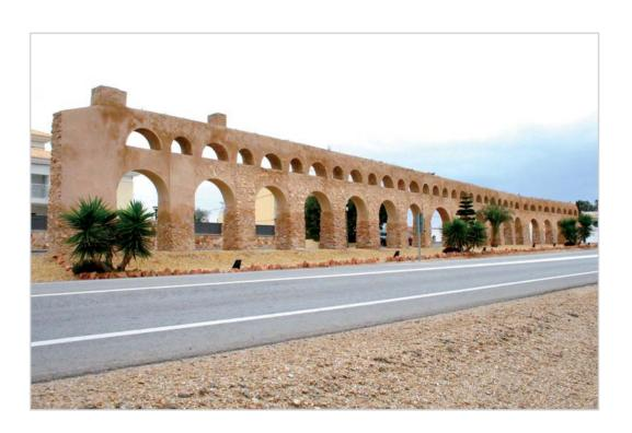
l acueducto que conocemos actualmente formó parte del "Complejo Hidráulico de El Real" construido hacia 1915. El complejo se compondría de una instalación hidráulica, con pozo de motor, alimentado a carbón primero y por energía eléctrica más tarde. Albergada en el edificio conocido como "la fábrica" y chimenea de humos (hoy desaparecidos).
