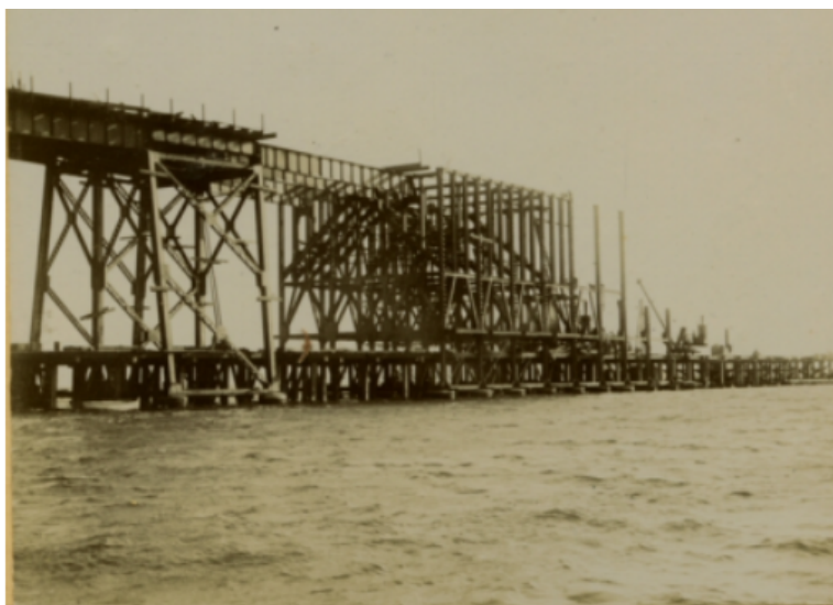
Fig. 1. Cargadero de mineral en construcción, año 1903. Archivo Diputación Provincial de Almería
