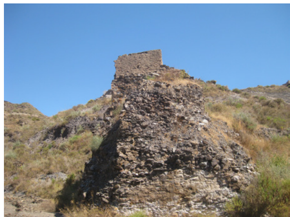
Figura 9.- Restos actuales del pozo de la mina Observación (Jaroso).
