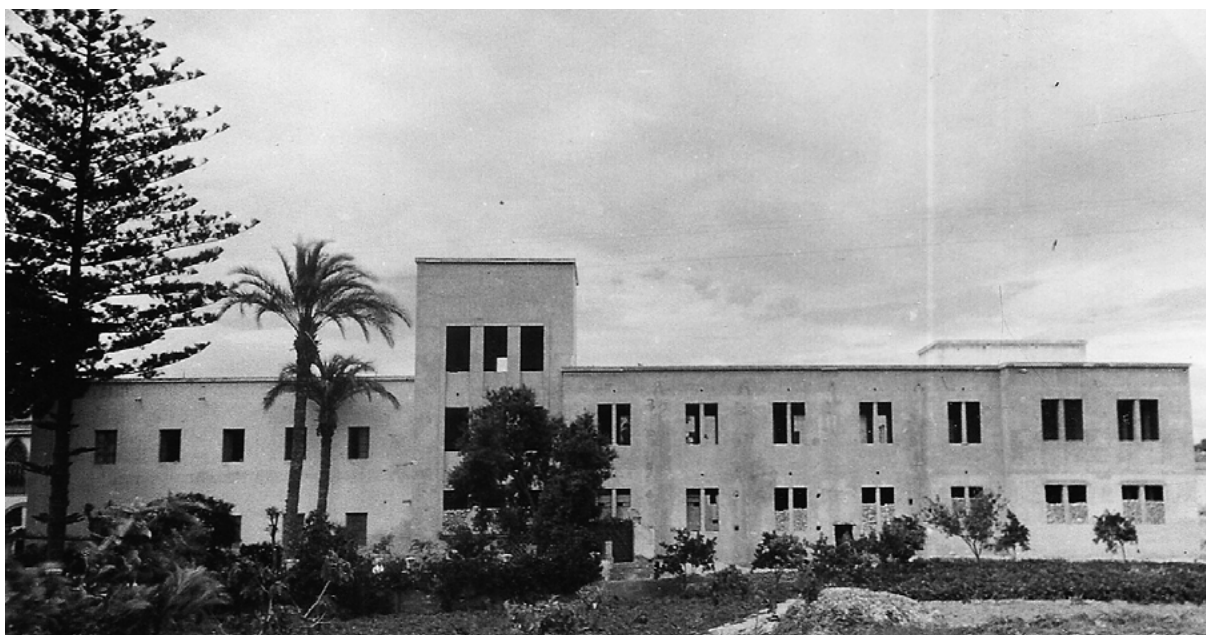
Pabellón de servicios centrales del manicomio, inaugurado el 18 de julio de 1962. Gentileza de Antonio Ramírez.
