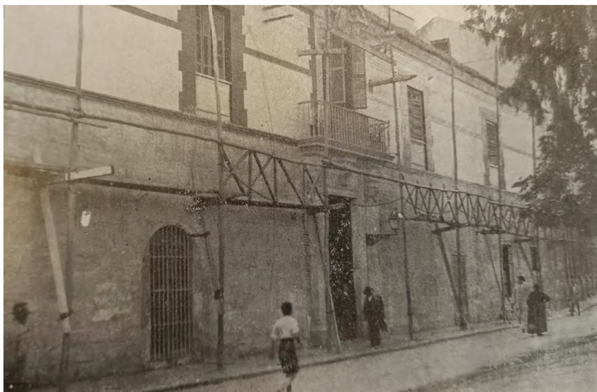
Fachada del Hospital Provincial en obras de reforma. Fuente: Cinco Años del Nuevo Régimen .
