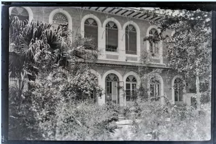
Patio del nuevo edificio de la Diputación. Fuente: Cinco Años del Nuevo Régimen .
