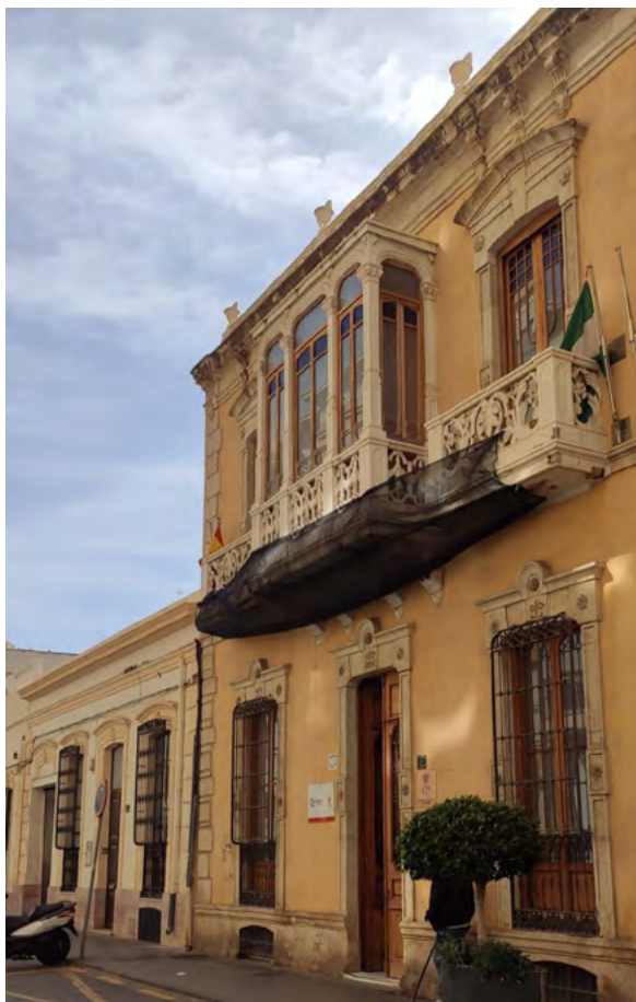
Estado actual de la antigua Casa de Socorro de Alcalde Muñoz, primera sede del Centro Provincial de Drogodependencias en 1986. Colección particular.
