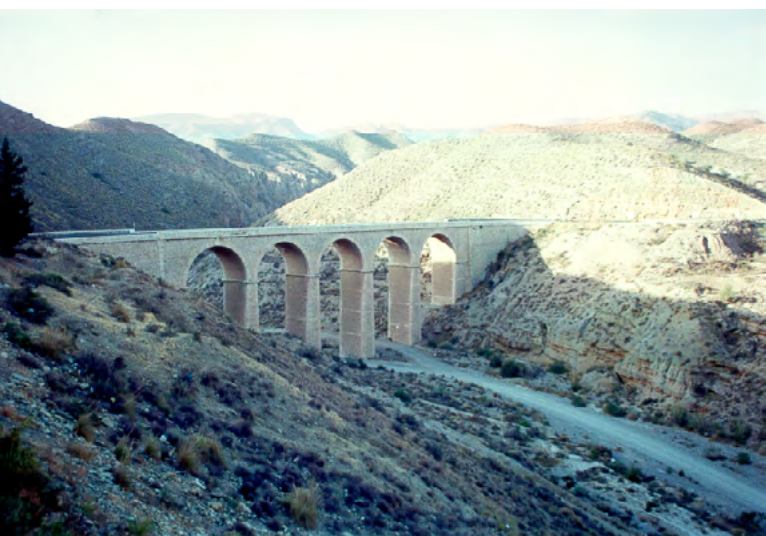
Viaducto de Huéchar, en la carretera de primer orden de la Estación de Vilches a Almería. Este fue una de las primeras obras de fábrica de cierto porte que se construyeron en esta carretera. Jean Laurent en su visita a Almería recogió el momento de su construcción a finales de la década de 1860. Fotografía del autor, 1999.
