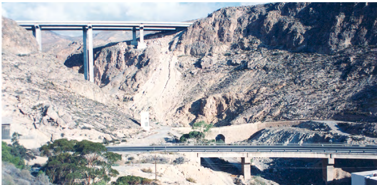
Puentes y viaductos en la carretera del Cañarete. En esta imagen se pueden ver tres obras de fábrica de tres periodos distintos: el pontón del camino de herradura que se utilizó en el siglo XVIII, el puente de la carretera de segundo orden de Málaga a Almería construido en la última década del siglo XIX y el gran viaducto de la autovía A-7 en construcción a finales del siglo XX. Fotografía del autor, 1999.
