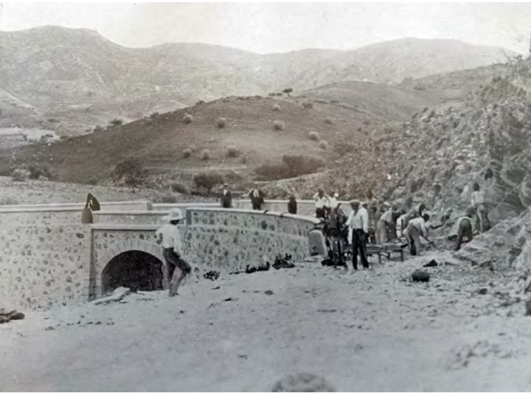
Construcción de camino vecinal Lubrín al Chive: Fuente: Cinco Años del Nuevo Régimen .
