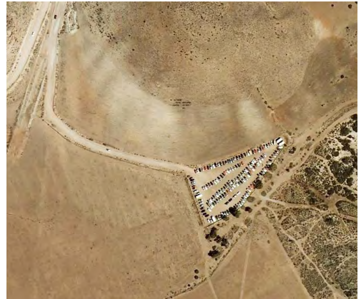
Estado actual. Detalle
