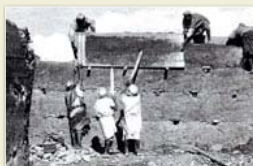
► Construcción de una muralla de tapial en Marruecos, principios del siglo XX
