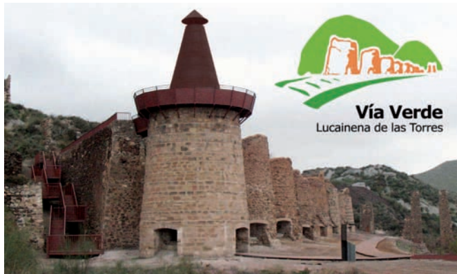
Torres de calcinación rehabilitadas (2011)
